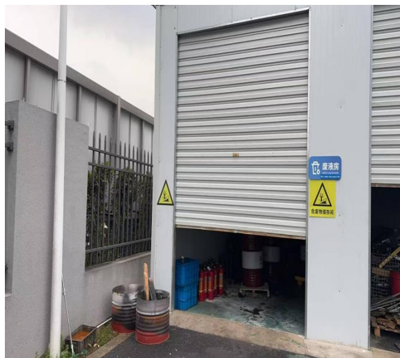
图 3-3 危废暂存间情况图
